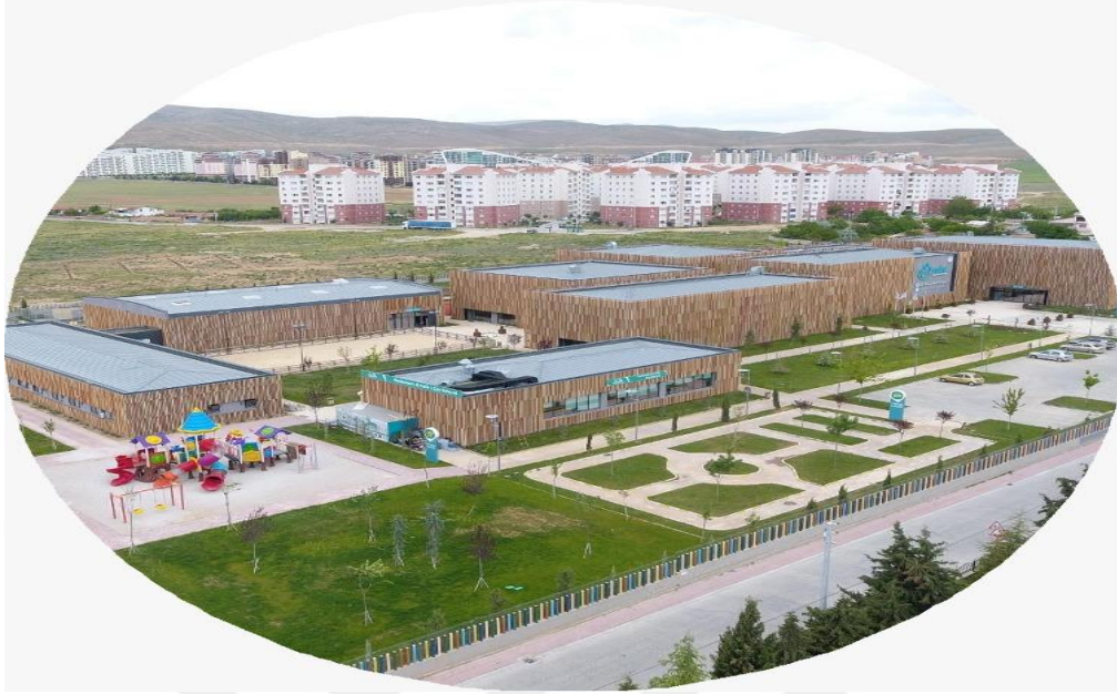
Şekil- 5. SOBE Vakfı Merkez Kampüsünün Dış Görünüşü
