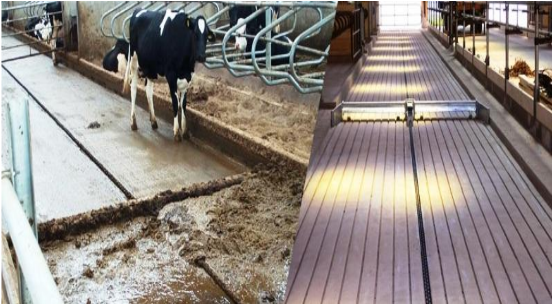
Şekil 2. 2. Süt sığırı barınaklarında gübre sıyırıcılarından görünüm. (Anonim, 2019)( navozu.net)
