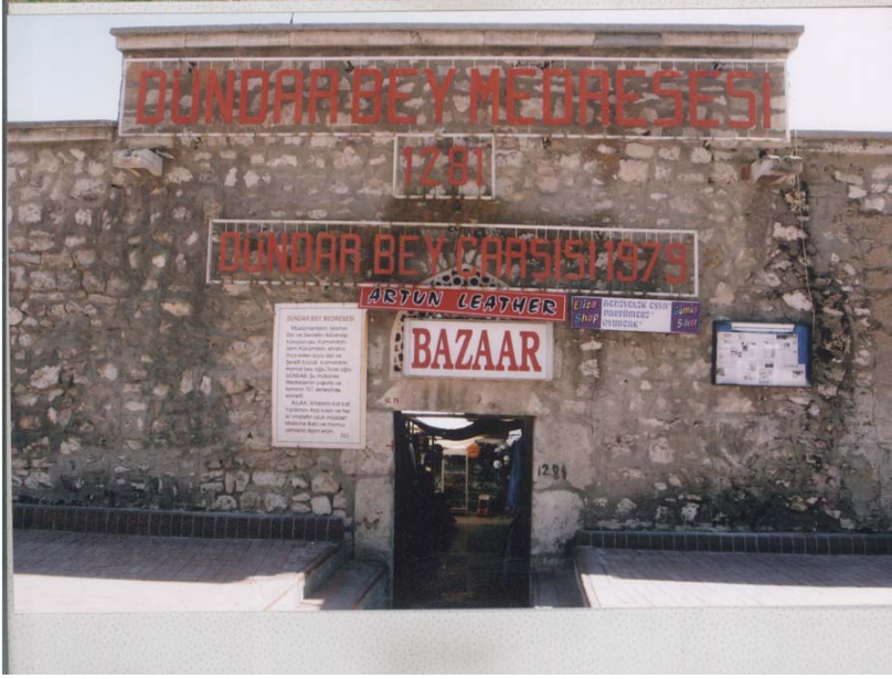
Foto: 4.6. Araştırma Sahasındaki Tarihsel Yapılardan Dündarbey Medresesi
