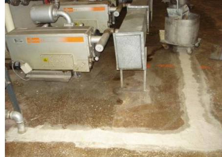
Vakum Şekil 11: 5S Sistematiği sonrası Vakum Tankı tahliye borusu
